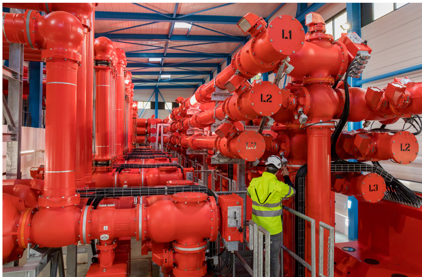
Drucküberprüfung einer Kammer der gasisolierten 220-kV-Schaltanlage in Romanel
