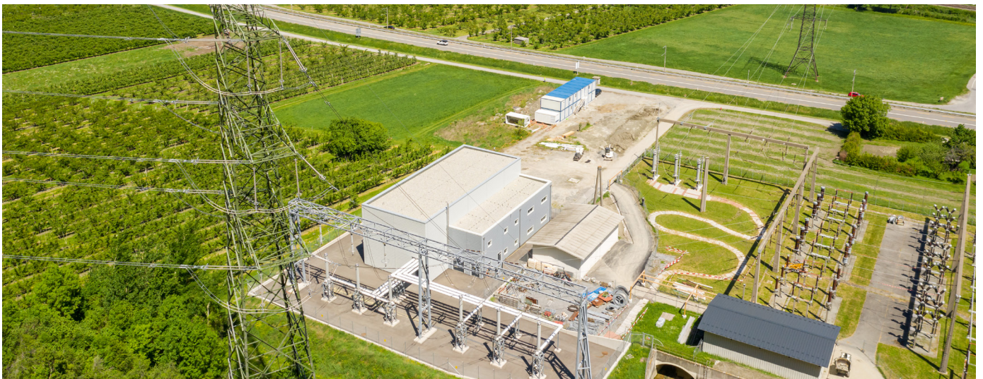
Beispiel einer gasisolierten Schaltanlage: Durch die kompakte Bauweise kann die benötigte Geländefläche um rund ein Drittel reduziert werden.
