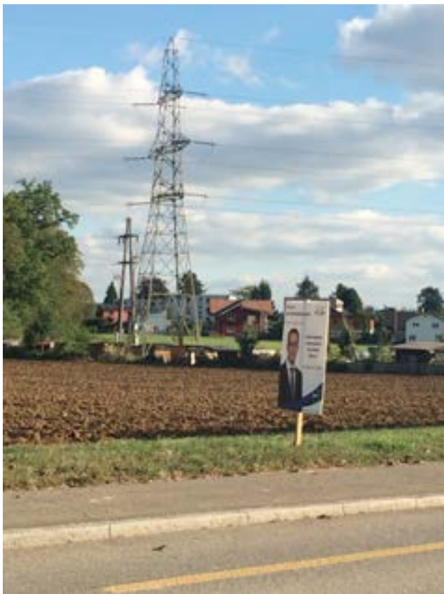
220-kV-Freileitung über dem Siedlungsgebiet in Riniken; die bestehende Trasse wird grossräumig verlegt und auf einem kurzen Abschnitt in den Boden gelegt. In niedrigeren Spannungsbereichen ist die Erdverkabelung bereits mehrfach ausgeführt worden.
